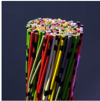
Abbildung 5.10: Ein Kabelbündel besteht aus mehreren Litzen, welche in gleichem Maße gezogen werden müssen. Hierzu sind besondere Befestigungsvorkehrungen zu treffen.
