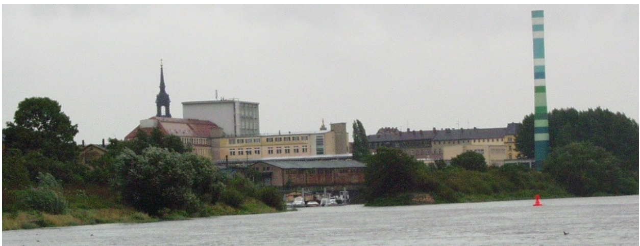
Abbildung 2-8: Elbe bei km 57,8 in Dresden: Öffnung zum Neustädter Hafen (am re. Ufer) von der Elbe aus gesehen. Foto: mit freundlicher Genehmigung BfG Koblenz (September 2001)
